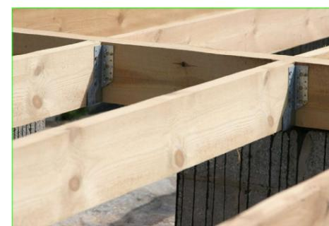
На данном листе показан пример размещения типовой обвязки 6x6 ,на свайном поле с дополнительными сваями под террасу. Так же терраса может быть организована с другой стороны здания. Расстояние между осями свай не должно превышать 3м!
